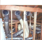
小屋根には、新鮮な空気を 取り入れて計画換気をする チューブが空つくり = 家康工務提供
