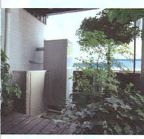
藤島建設が開発した 地中熱を利用したヒートポンプ(前)と 給湯タンク(後)、冷暖房から、 給湯、暖房まで地中熱を使う
